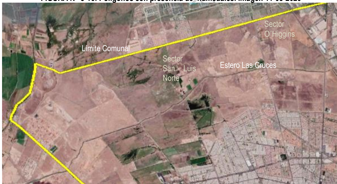
FIGURA N° 3-16: Polígonos con presencia de humedales. Imagen 11-03-2020
